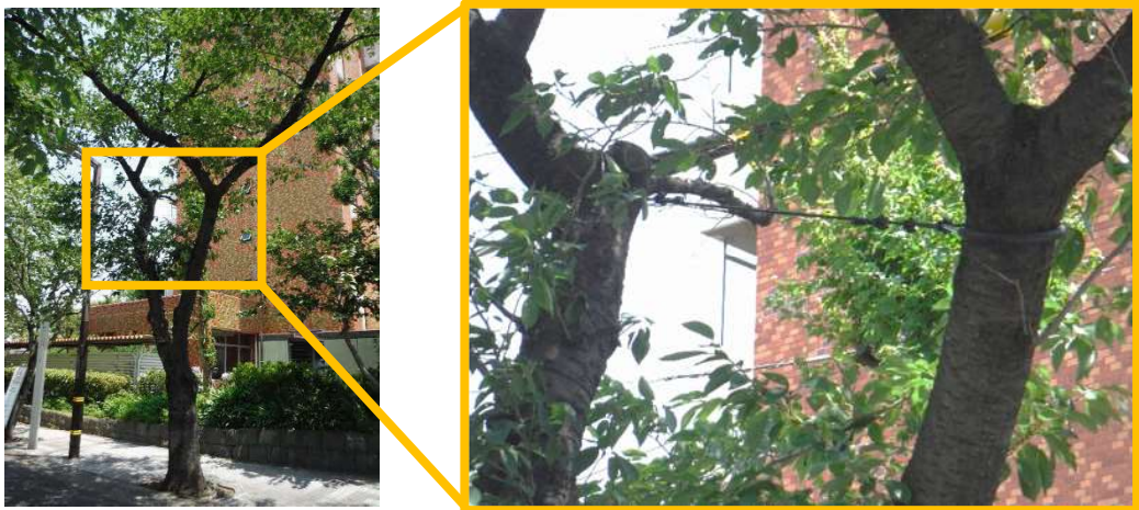
ワイヤー設置状況
