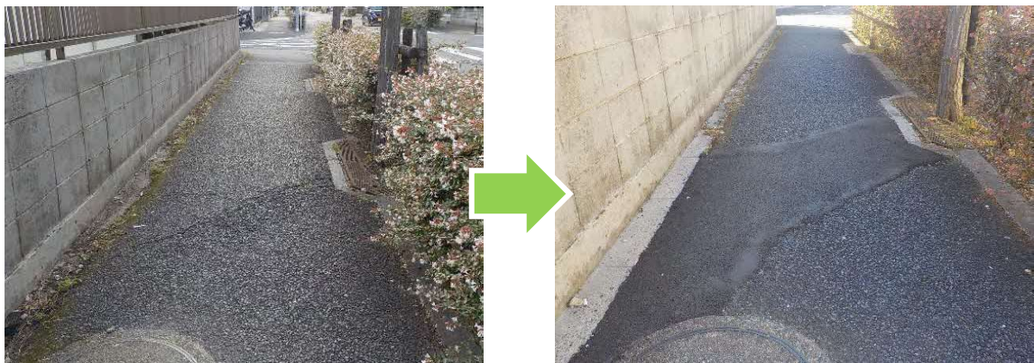
巡回点検委託業者による根上がりの補修
