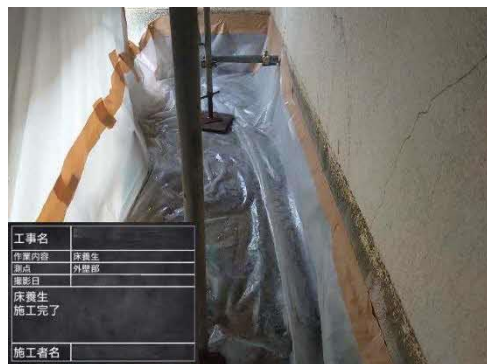
壁面下部養生
