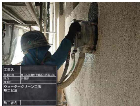
超高压水洗工法による除去
