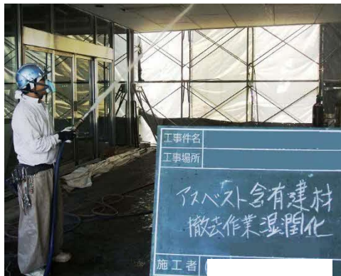
石綿飛散防止剤を散布
