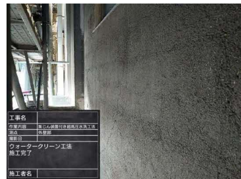
除去完了状況
