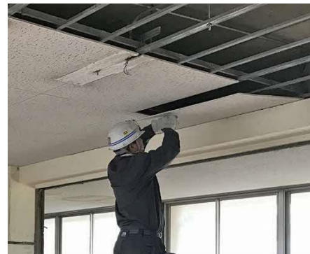
人力撤去作業
