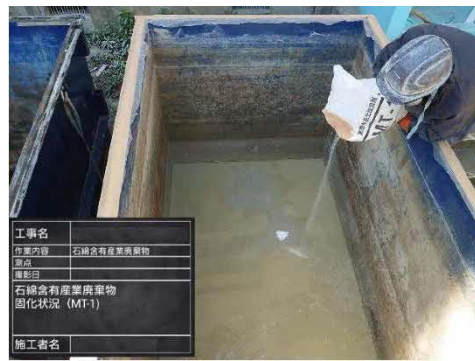
撤去物を沈降・固化 させ袋詰・集積・保管
