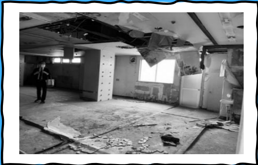
▲ 綾瀬駅西口高架下空き店舗の現状
