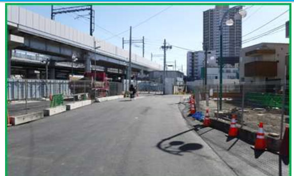
電線共同溝工事実施箇所
