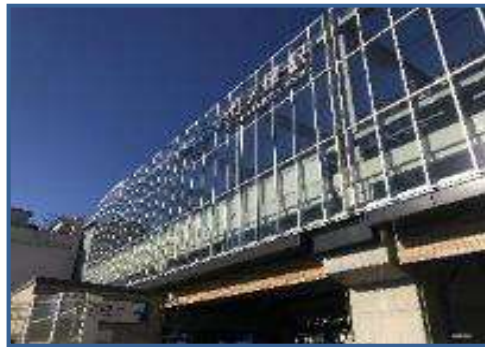
新駅舎建築工事の状況
