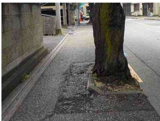
根による舗装や縁石の持ち上がり
