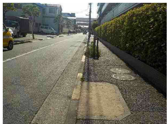
新たに植栽できない狭い歩道
