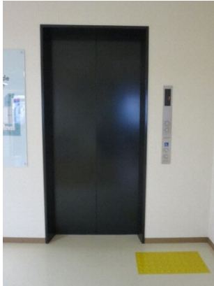
エレベーターの設置
