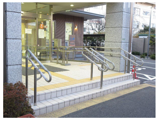
視覚障がい者誘導用ブロックの設置
