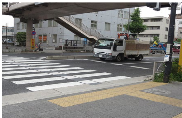
音響機能付信号・エスコートゾーンの整備
