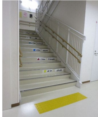
二段手すりの設置
