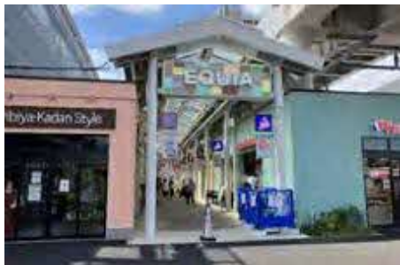
▲高架下商業施設
