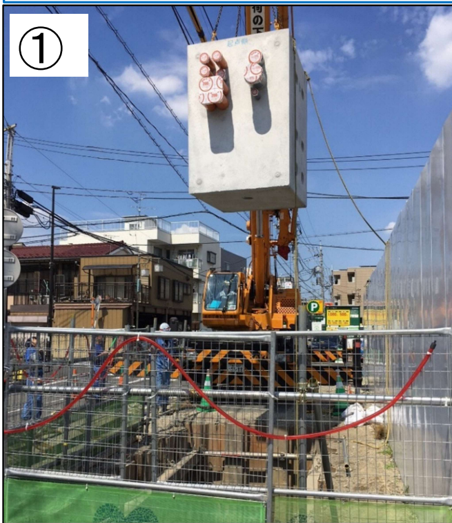
特殊部(コンクリート製の箱)の 吊り上げ状況
