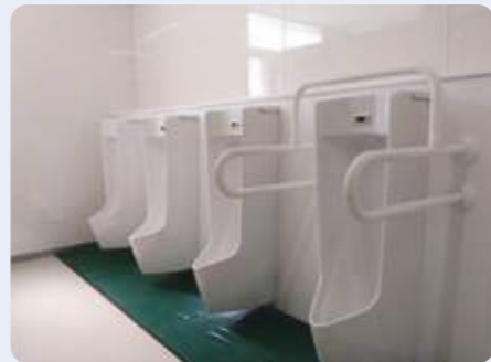
改修工事で使いやすくリニューアルされたトイレ
