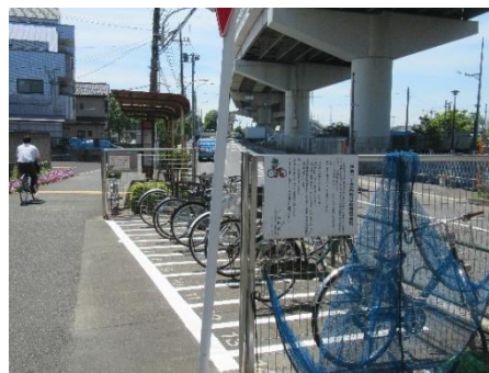
新設された神明一丁目駐輪場
