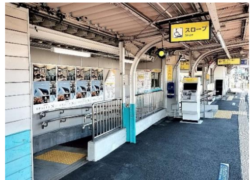
堀切駅に設置されたスロープ
