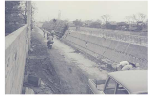
綾瀬川堤防かさ上げ工事（昭和40年代）
