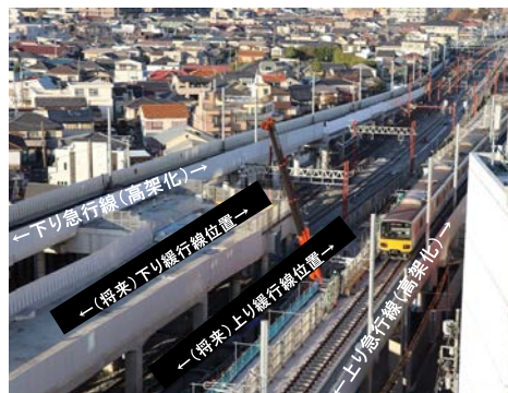
▲竹ノ塚駅付近 上り急行線高架化
