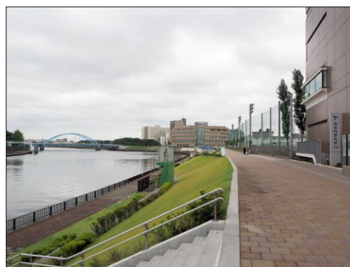
緩傾斜型堤防と一体となって 整備された隅田川沿いの地区 (千住桜木一丁目)
