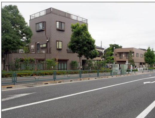
無電柱化された道路 (舎人公園通り)
