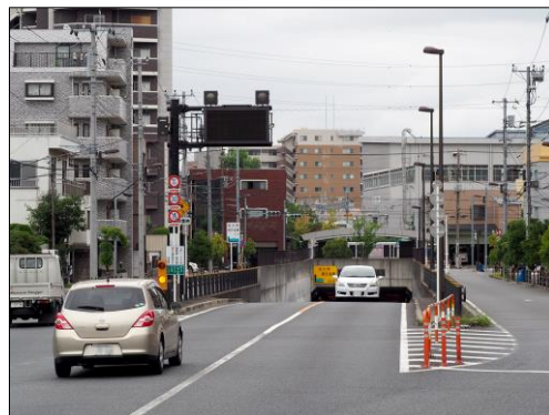
加平谷中トンネル (東京地下鉄千代田線の車両基地を補助 258 号線がアンダーパス)
