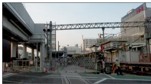
事業中の竹ノ塚駅付近の鉄道の高架化
