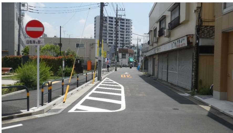
歩道の整備事例（江北）（P23、A 矢視）
