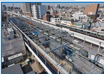
新駅舎建築工事の状況
