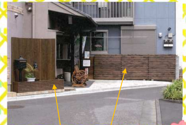
エコ機能ウォール(雨水タンクを内蔵し、国産木材・間伐材を利用(平成27年度助成))
