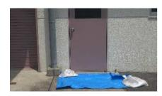
土のうの結び目を建物側にして、重ねます。 このとき、手で面を平にして、隙間ができないように半分くらい重なるようにします。
