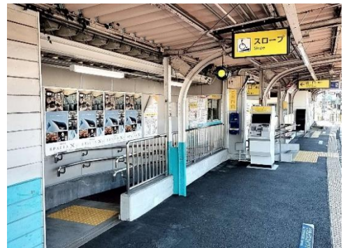
堀切駅に設置されたスロープ
