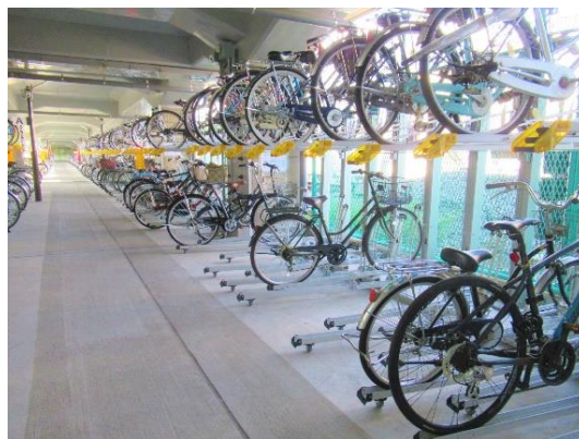
北綾瀬北自転車駐車場（区営）
