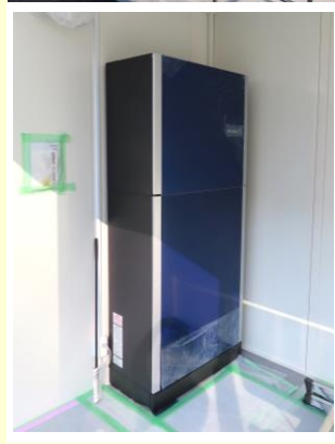
▲室内に設置するプラズマ脱臭装置
