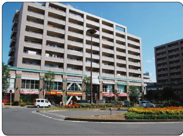
共同化により建設された建物 鎌ヶ谷駅東口駅前広場の様子
