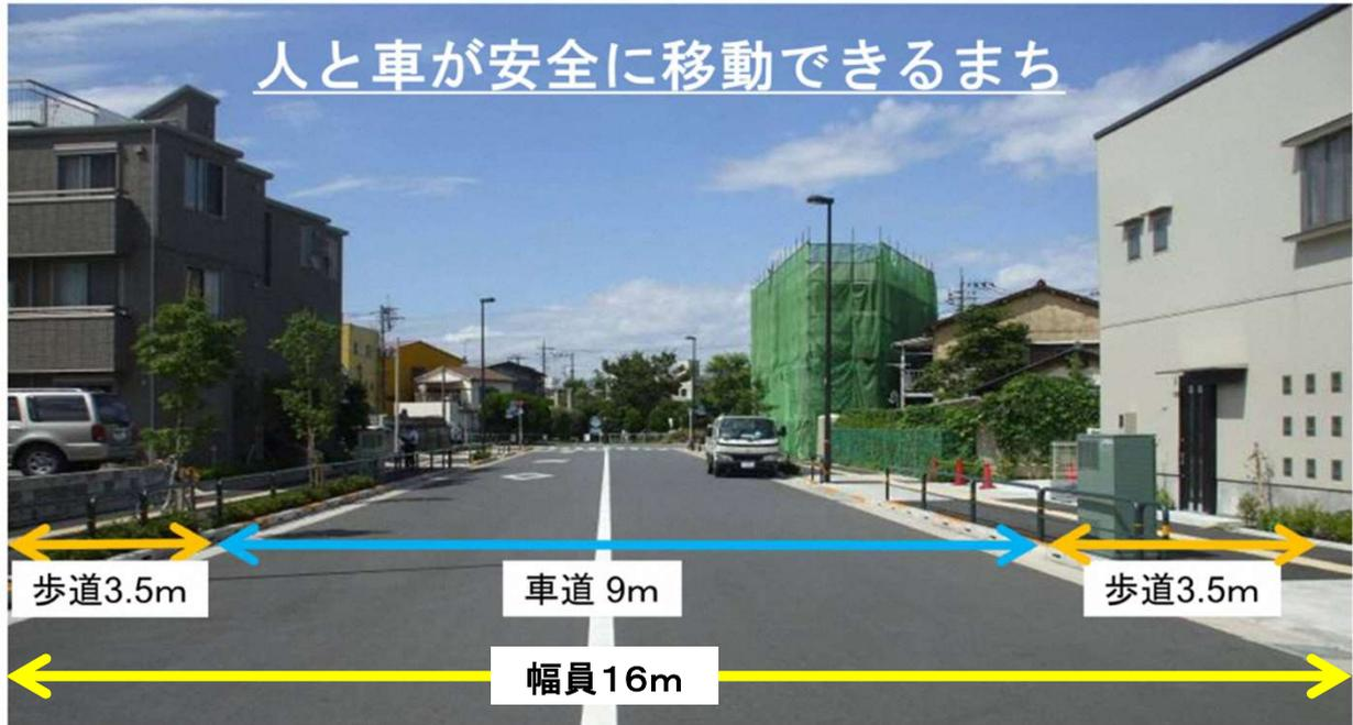
補助第255号線は、計画幅員が15mの区間と16mの区間があります。
