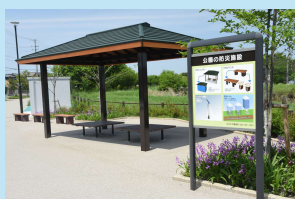
災害時に四方をテントシートで囲い、救護室や倉庫などに利用できるパーゴラ
