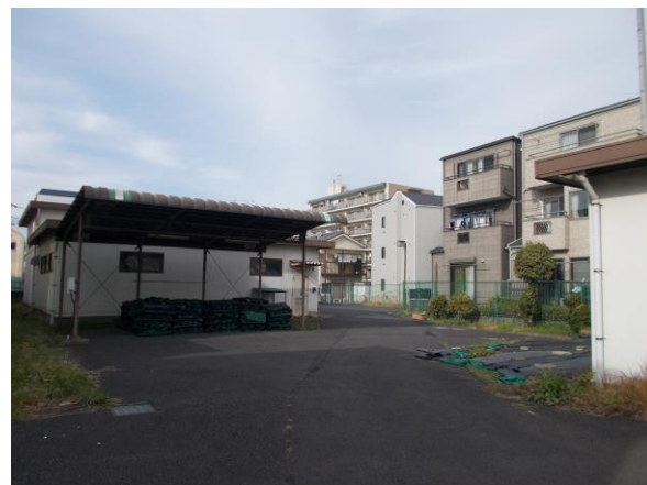
4 (旧) 綾瀬器材置場
