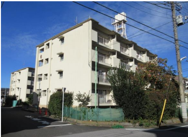
1 2-2 大谷田二丁目アパート (6号棟)
