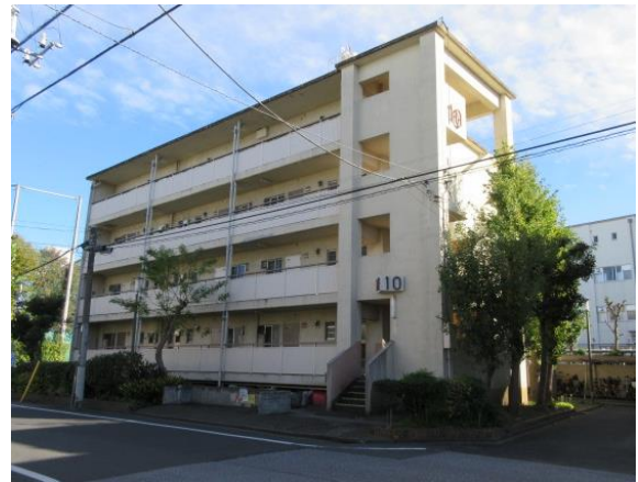
1 3 大谷田二丁目アパート (10号棟)
