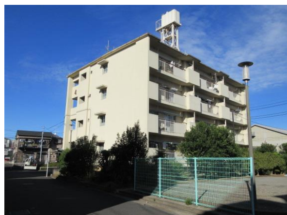
12-1 大谷田二丁目アパート (4号棟)
