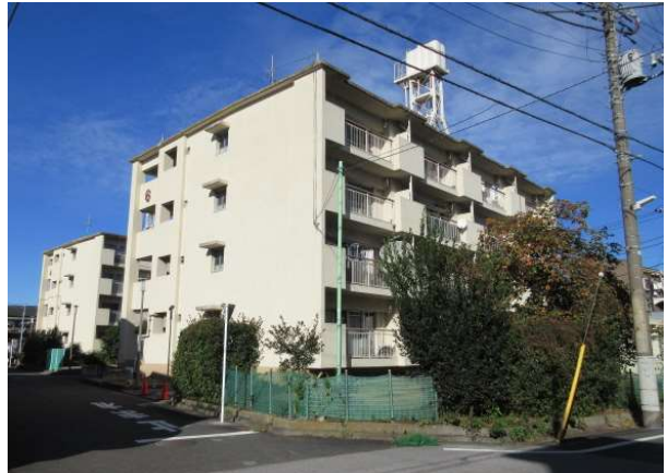
18-2 大谷田二丁目アパート (6号棟)
