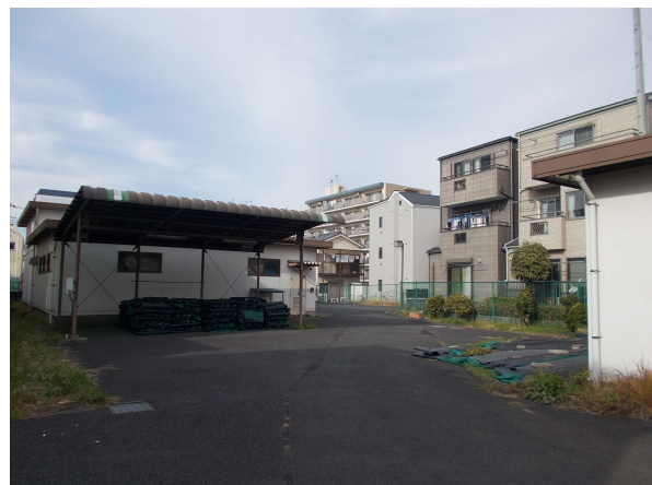
6 (旧) 綾瀬器材置場
