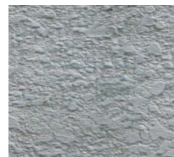
剥離剤塗付 (放置後)
