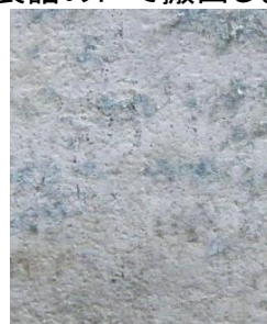
外壁材除去完了
