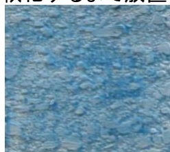
剥離剤塗付 (塗付直後)
