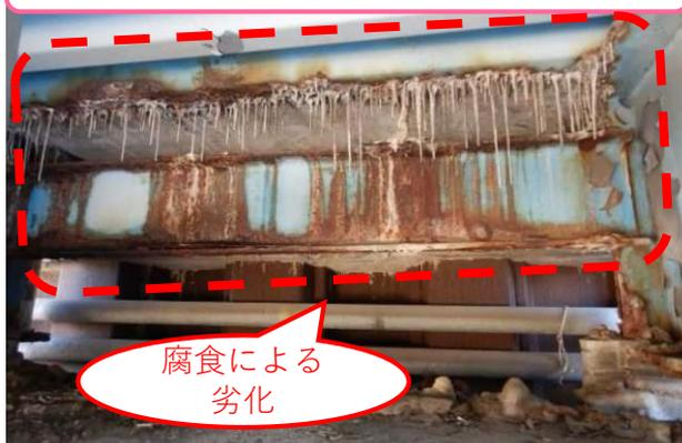
写真② 主桁の劣化状況
