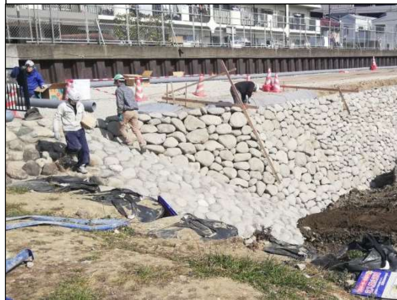
護岸工事 (令和6年2月時点)
