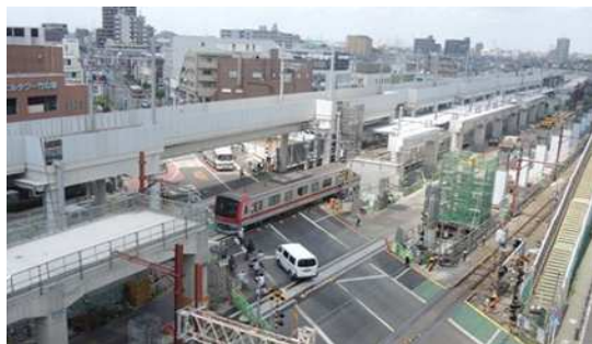
【竹の塚エリア】鉄道高架化事業が進行中▲
