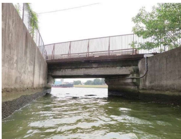
図4 3 t 車規制の築93年の花見橋
