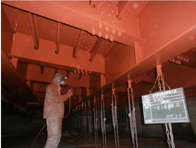
図9 月見橋の塗裝修繕工事
