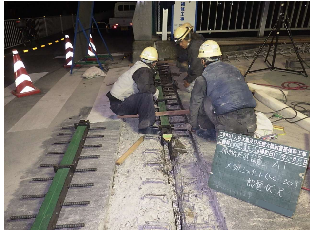
図10 花畑大橋の伸縮装置交換工
