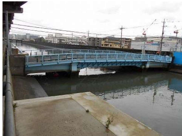
図5 14 t 車規制の築90年の綾瀬新橋
