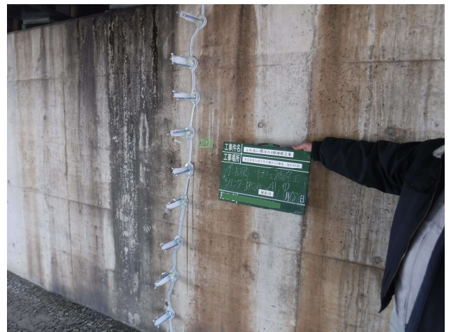
図12 毛長橋の修繕工事
