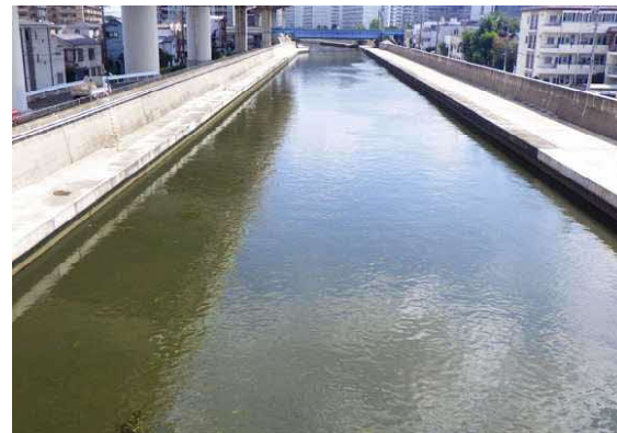
▲護岸耐震補強工事の完了した綾瀬川
