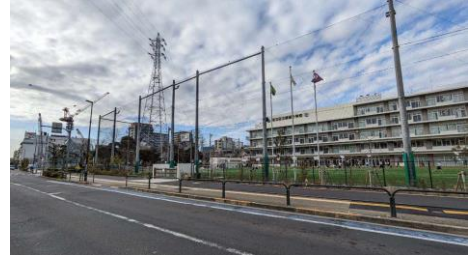
■改築後の綾瀬小学校及び駅前通り
