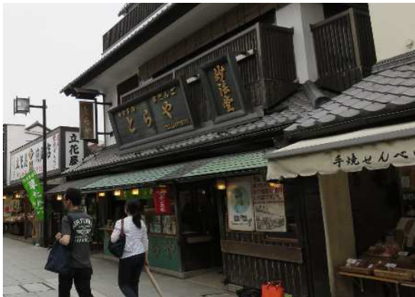
1階庇とともに設置された屋根看板の例
