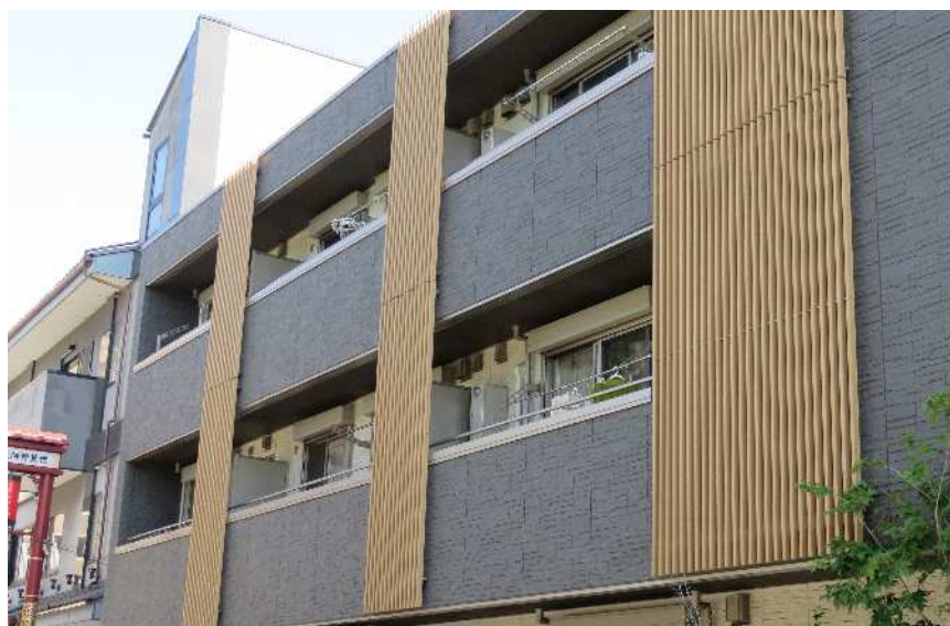
共同住宅のバルコニーの設備類を木格子風のルーバーで目隠ししている例
