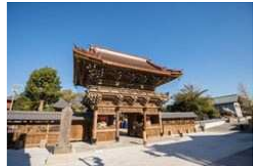
江戸後期に建立された山門 ：平成29～30年【2017～18年】 に修復工事を実施した。
