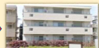
② 燃えにくい建物へ建替わりました
