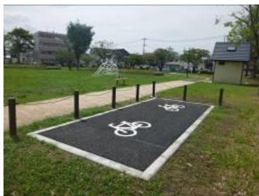
公園改修工事で駐輪場を設置 (舎人十二号公園)
