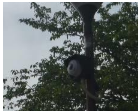
防犯カメラの設置 (舎入いきいき公園)
