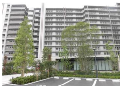
良好な緑化事例（集合住宅）
