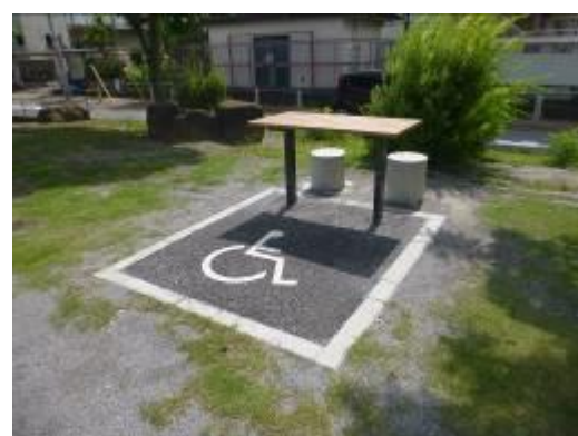
公園改修工事で車椅子用テーブルを設置 (舎人いきいき公園)
