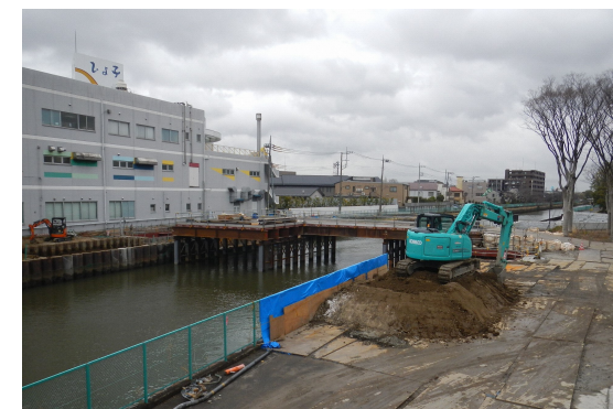
足立区側の工事の様子
