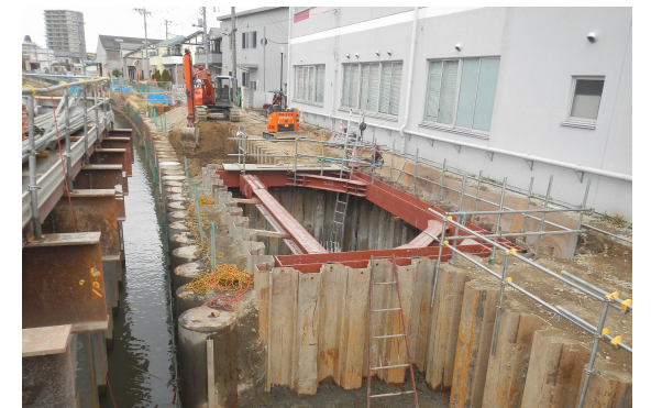
草加市側の工事の様子
