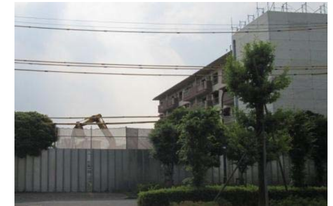
■解体工事中のA・B街区
