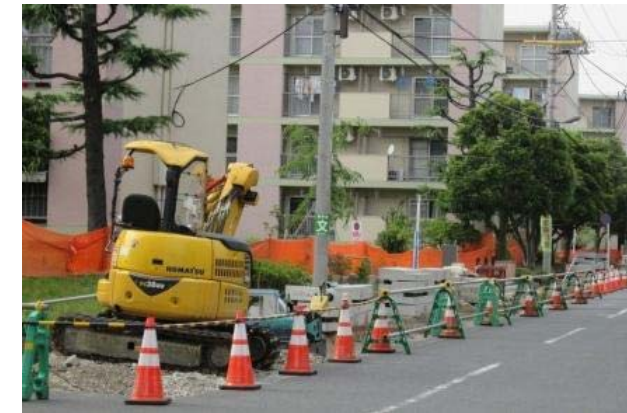
■歩道拡幅工事の様子
