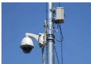
防犯カメラ設置の様子
