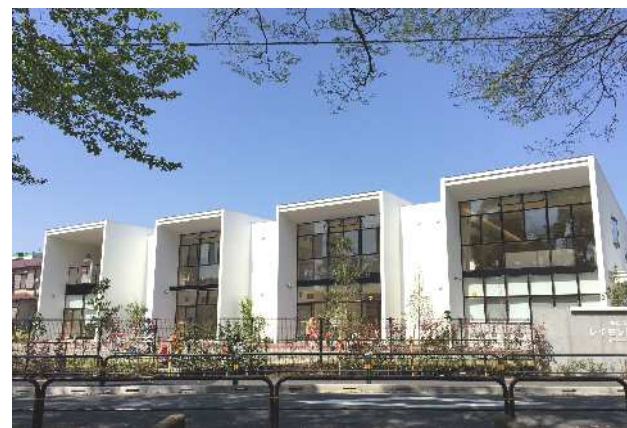
大きな窓が印象的な建物の外観
