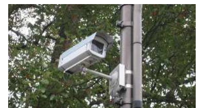
防犯カメラ設置の様子
