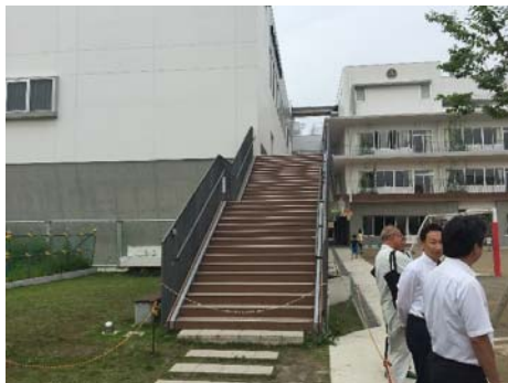
体育館と校舎に接続している階段
