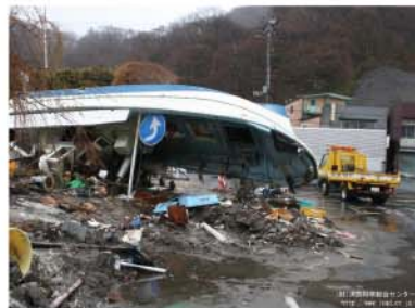
▲津波被害(東日本大震災)※
