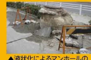
▲液状化によるマンホールの 浮き上がり(東日本大震災)※
