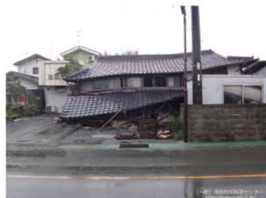
▲住家被害(熊本地震)※
