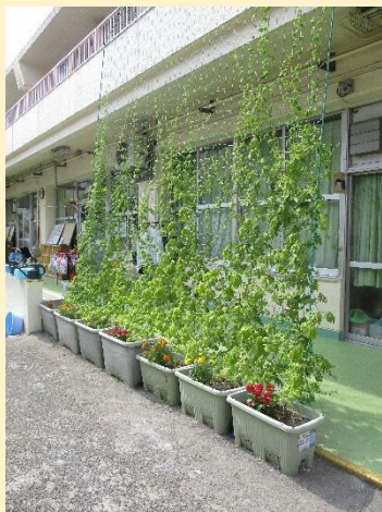
保育園に設置した 緑のカーテン
