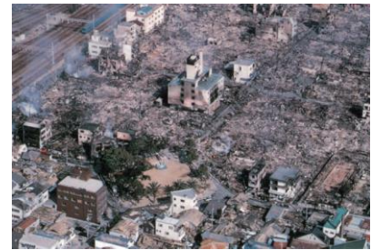
火災発生時に 焼け止まりとなった公園 出典：「未来につなぐ都市と緑」 （国土交通省）
