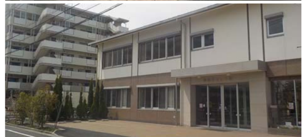
上：建替えられた住棟と公園／下：創出用地に整備された障がい者施設
