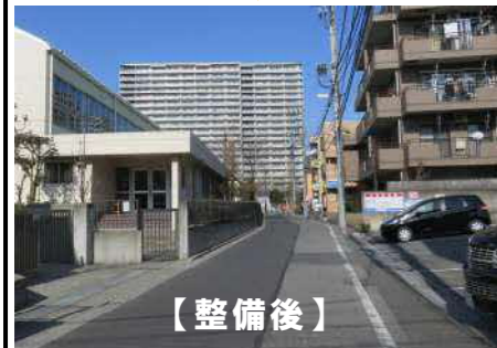
両側拡幅により幅員6mに整備
