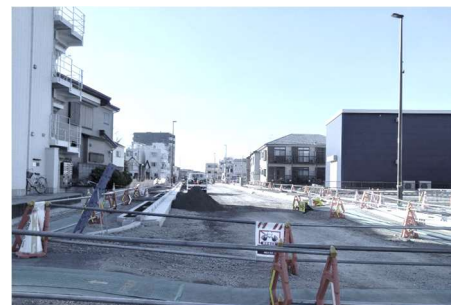
■その2工区の道路築造工事
