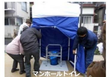
マンホールトイレの上に便座とテントを設置すると、災害時のトイレとして使用できます。
